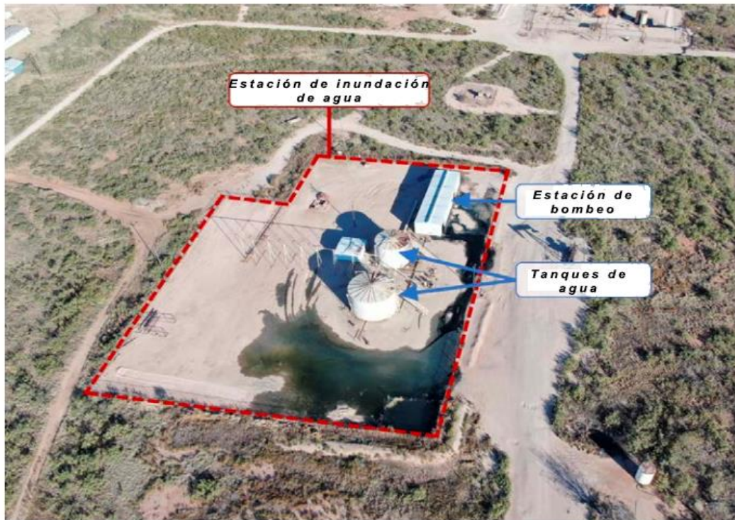
Figura 2. Vista aérea de la estación de inyección de agua Aghorn Operating en Odessa, Texas, a la mañana siguiente del incidente. (Crédito de la foto: Ector Oficina del Sheriff del condado, destacada por la Junta de seguridad química de EE. UU.)
