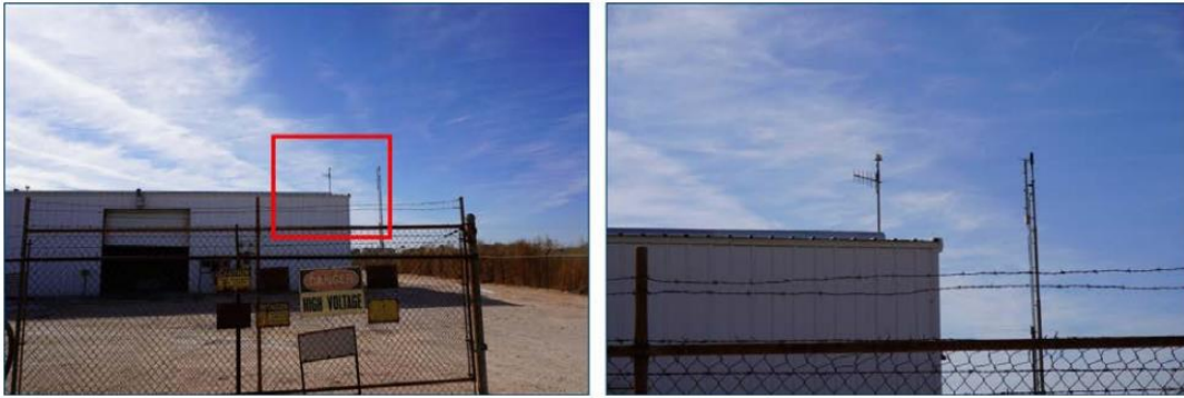
Figura 3. Luz diseñada para iluminar cuando se detecta sulfuro de hidrógeno en las instalaciones.
