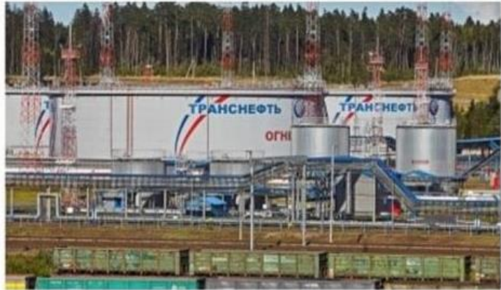
Instalación de almacenamiento de Transneft - Imagen: Shutterstock
