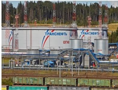
Instalación de almacenamiento de Transneft – Imagen Shutterstock
