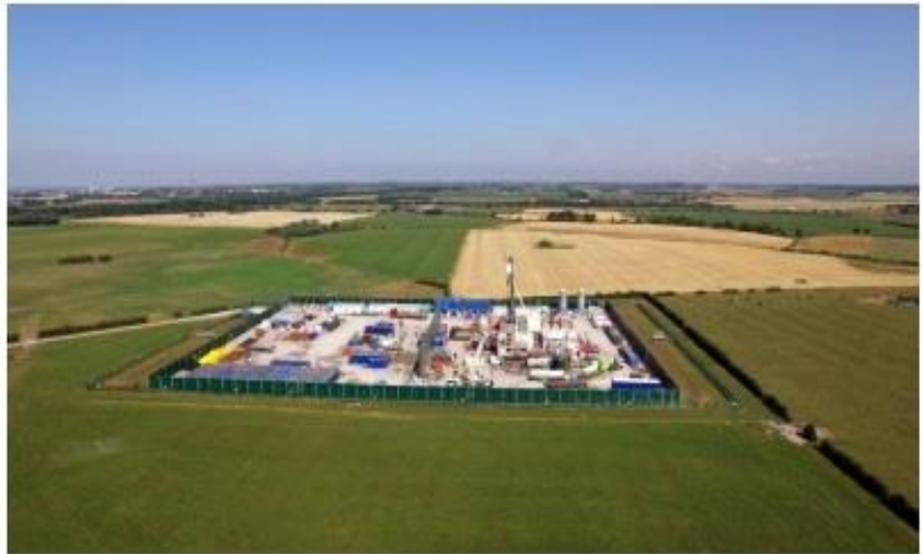
Zona Preston New Road-Imagen:Cuadrilla Resources
