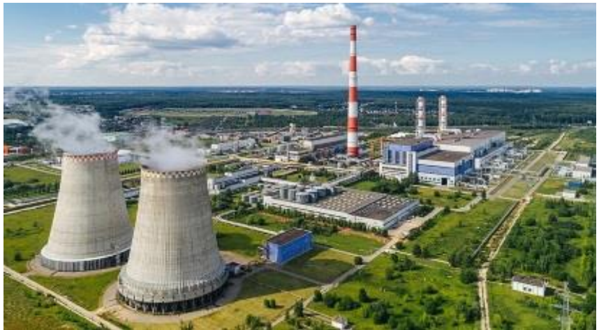
Planta de Generación térmica Severnaya -Imagen: Mosenergo PJSC / Anna Samarina
